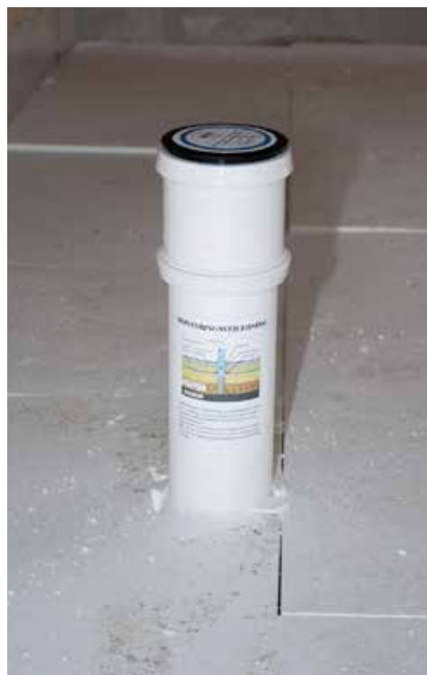
Radonbrønn plassert i grunnen før radonmembran har blitt lagt.
