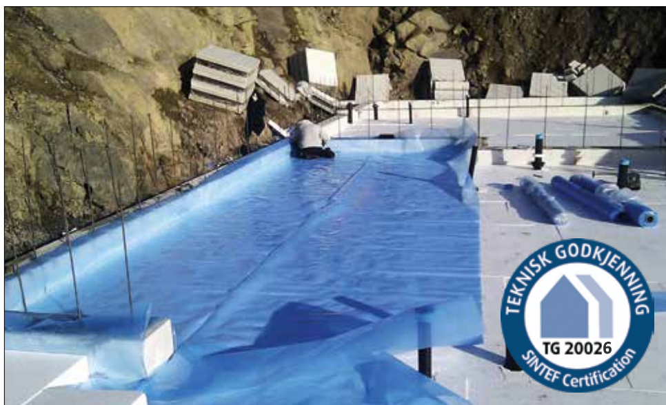
Rad(ON) er en av de tetteste radonsperrene på markedet og sammen med tilbehøret så kan bygninger beskyttes meget effektivt mot inntrenging av radon.
